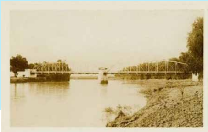
Jembatan bacem sebelum mengalami pemugaran. Jembatan ini menjadi situs pembantaian terhadap orang-orang yang diduga PKI dan simpatisannya pada tahun 65-66. Foto: ELSAM.
